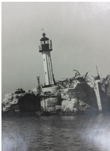
Figure 36 Photographie de l'ouvrage après bombardement
