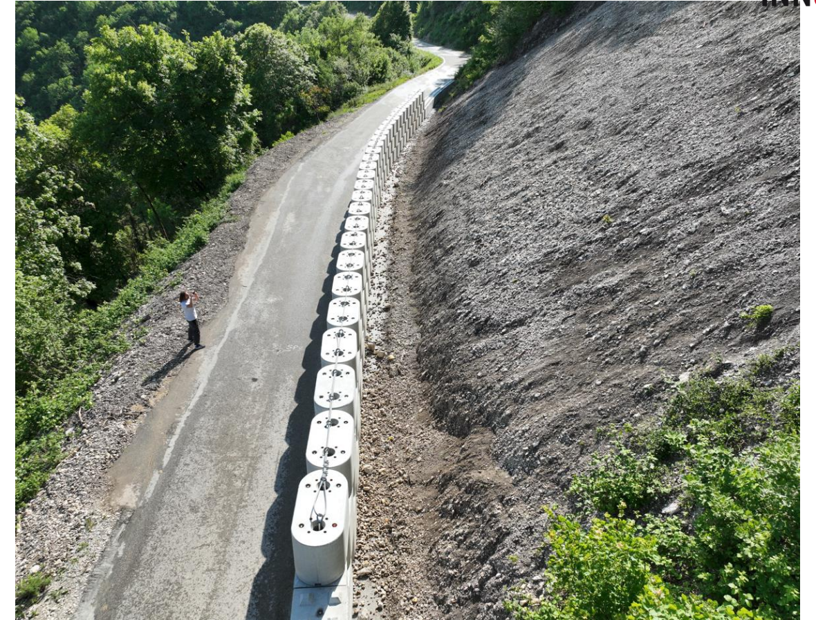
Merlon Blocs Armés et fosse de stockage
