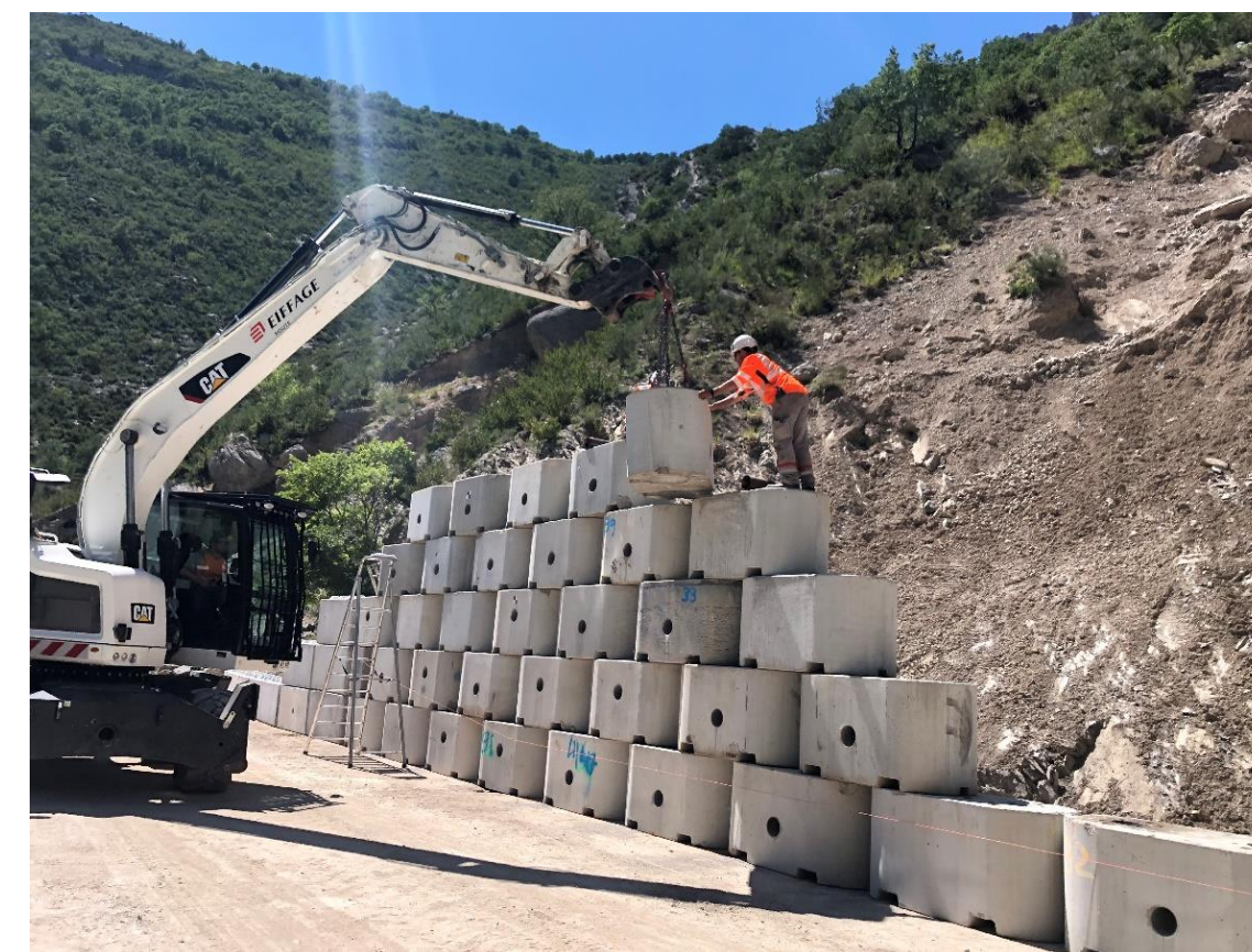
Montage du mur de 20 m, 67 blocs Par une équipe de 6 personnes, en une journée
