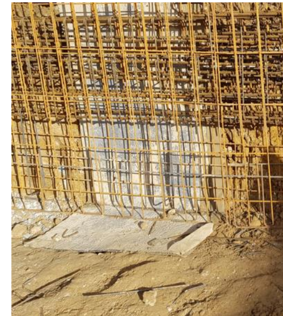
Illustration de la pose du drainage vertical dans la réalisation de voiles par passes
