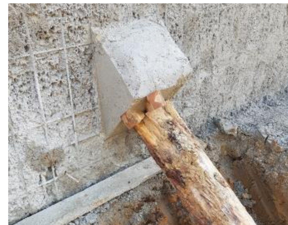
Buton serré par des coins au niveau du corbeau
