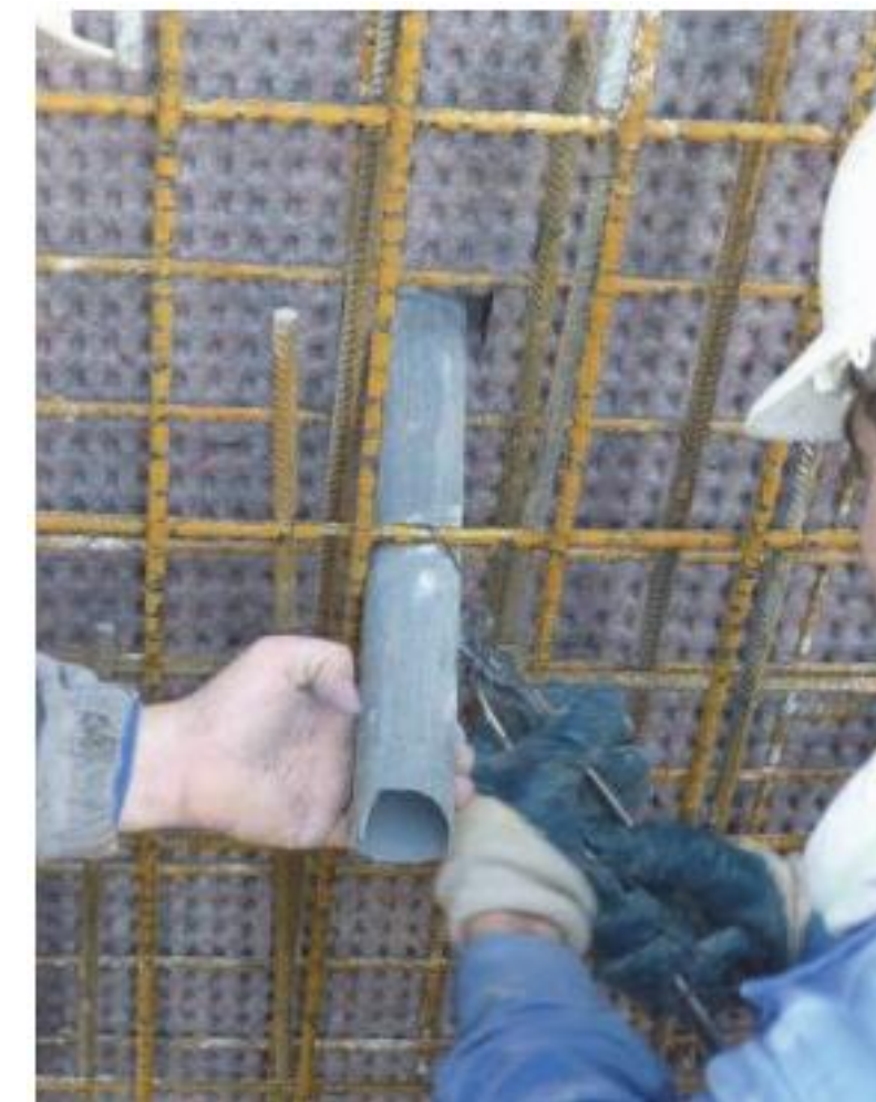
Illustration de la pose d'une barbacane et de la connexion avec le drainage vertical
