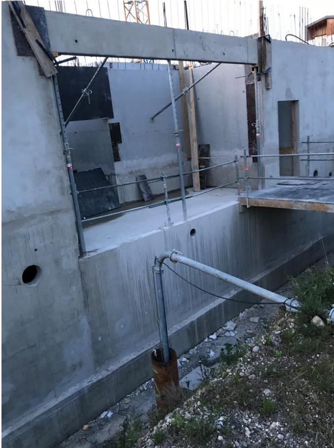
Importance du suivi de pompage pendant la phase travaux
