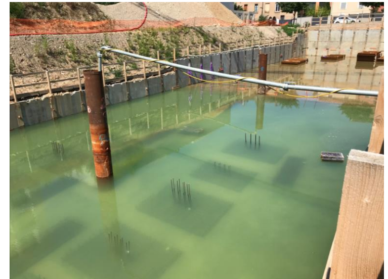
Cycles de pompage → ne pas oublier l'impact sur le « chemin des contraintes »
