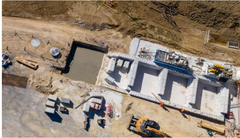
Fosses à déblais en blocs béton en cours de réalisation (CDG Express Zone F)
