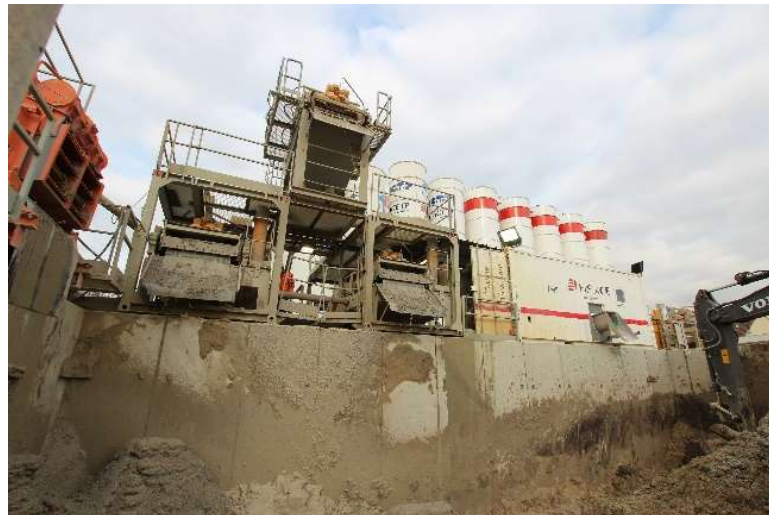
Fosse réalisée avec des murs en L (Ligne 16 Lot 1)
