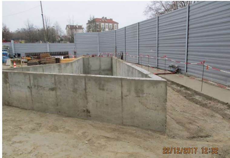
Fosse à déblais réalisée en génie civil (Ligne 15 T2B, 902P)
