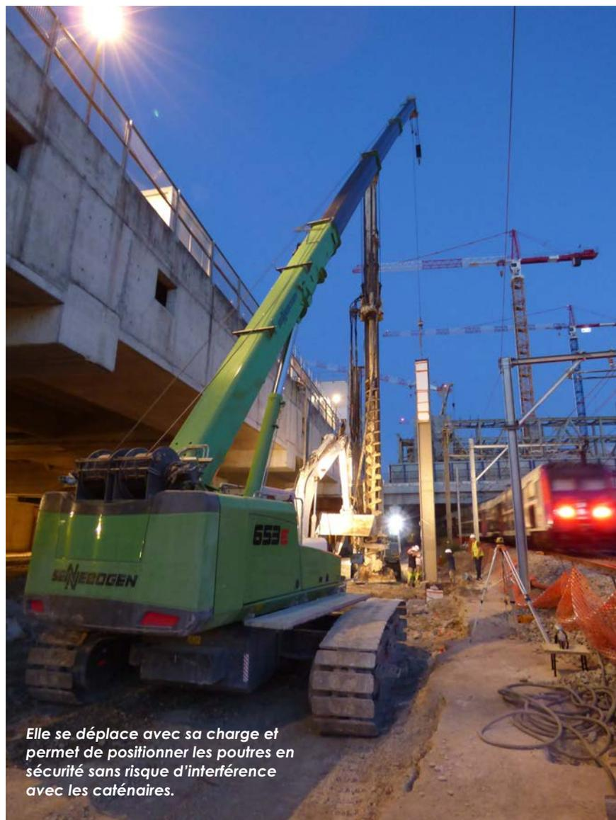
Elle se déplace avec sa charge et permet de positionner les poutres en sécurité sans risque d'interférence avec les caténaires.
