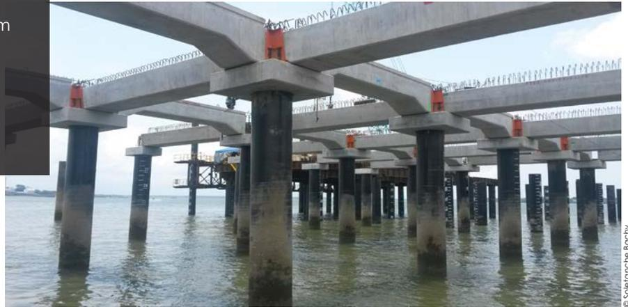
Installation des poutres, coffrage et bétonnage des nœuds.
