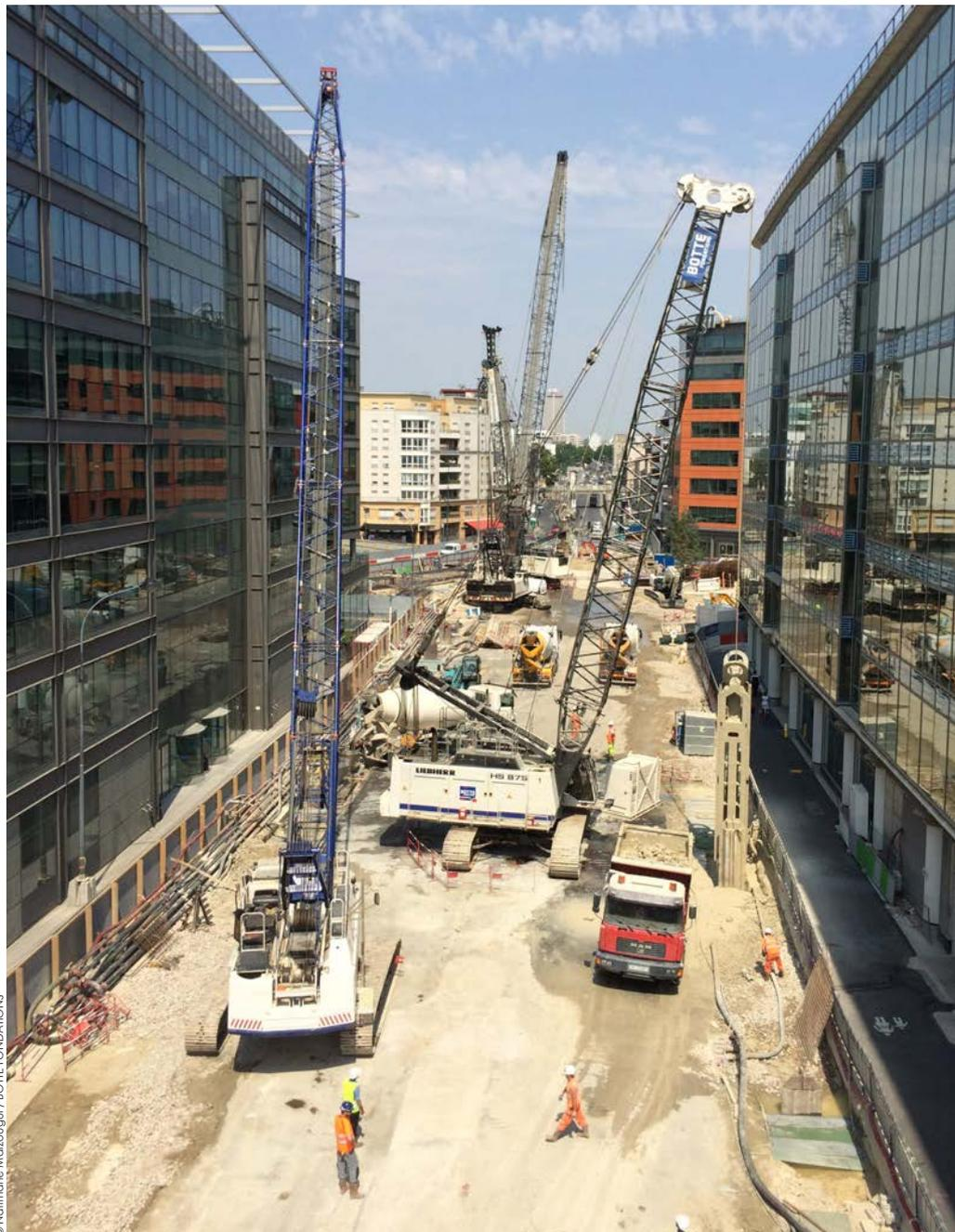
Sur ce chantier de la station Mairie-de-Saint-Ouen, Botte Fondations réalise des travaux d'injection et de fond d'injection, des parois au coulis et des parois moulées de profondeur, du jet grouting...
