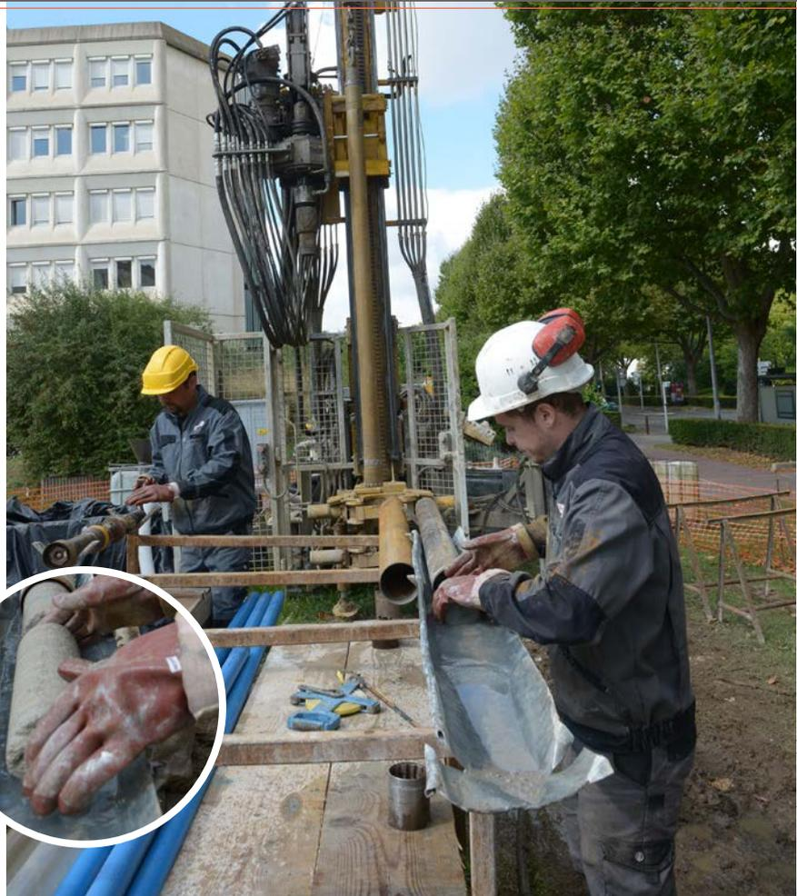
Carottage à Créteil avec pose d'un équipement piézométrique à 37 mètres de profondeur.
