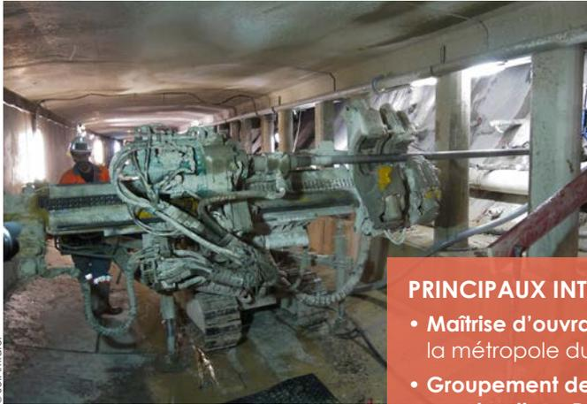
Forage avec machine à gabarit réduit MC-4D dans la galerie à air frais.
