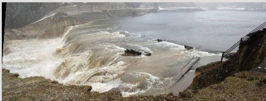
**Rupture du barrage de Fujinuma par surverse, le 11 mars 2011, à 15 h 10, suite à d'importants déplacements irréversibles (> 1,5 mètre), provoquée par le grand séisme du Tohoku au Japon (magnitude 9). Première rupture de grand barrage due à un séisme causant la perte de vies humaines (8 personnes).**
