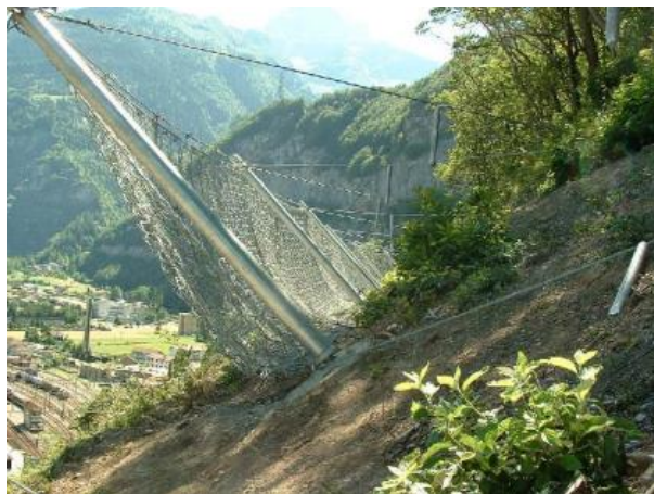
Ecran de filets pare-blocs haute énergie (crédit : risknat.org)
