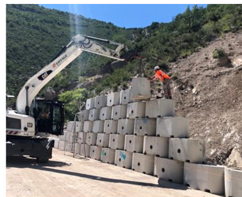
Longueur : 21 m; Hauteur : 4m (5 rangées); 60 blocs
