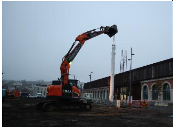
h Maintenance d'une cage d'armature équipée de chaussette à béton
