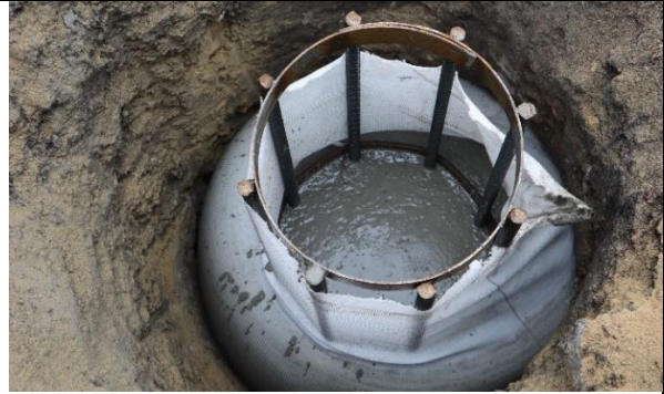
f Pieu coulé avec une chaussette à béton
