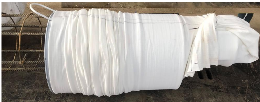
a Photo prise en condition réelle de la tuyère (virole) permettant l'enfilage de la chaussette sur la cage
