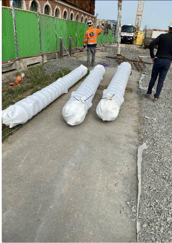
e Cages d'armatures équipées de chaussette à béton
