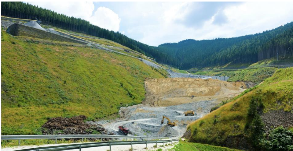
Figure 11 : Site de dépôt. © ÖBB/Ebner
