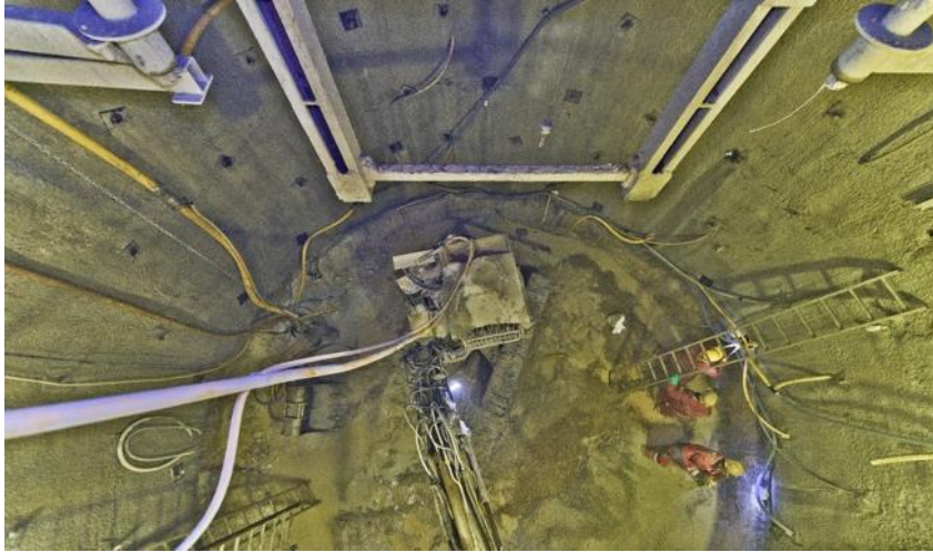
Figure 8 : Vue du puits pendant la construction. © ÖBB/Ebner
