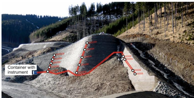
Figure 11 : La géogrille et les câbles de détection ont été déployés à l'intérieur de la structure de soutènement. © IGMS, TU Graz
