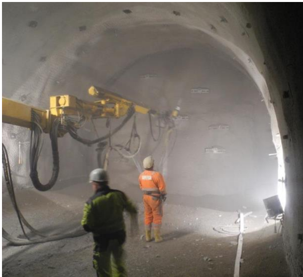
Figure 5 : Application de béton projeté. © IGMS, TU Graz
