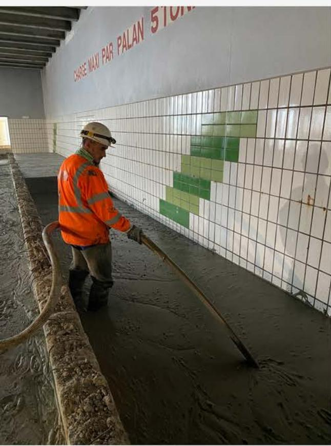
AEROLITHYS® offre une compacité homogène sur toute la hauteur du remblai et permet ainsi de prévenir les risques de tassement différé.
