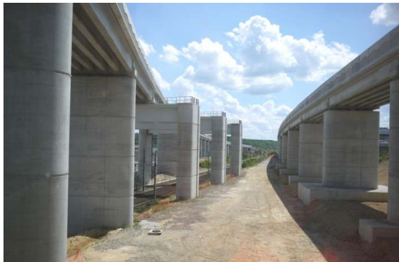
Viaduc de la Folie – LGV SEA
