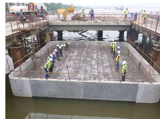
Second Pont sur le Wouri (Cameroun)
