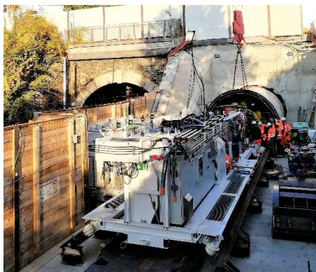
Galerie de sécurité d tunnel de Meudon (RER C)
