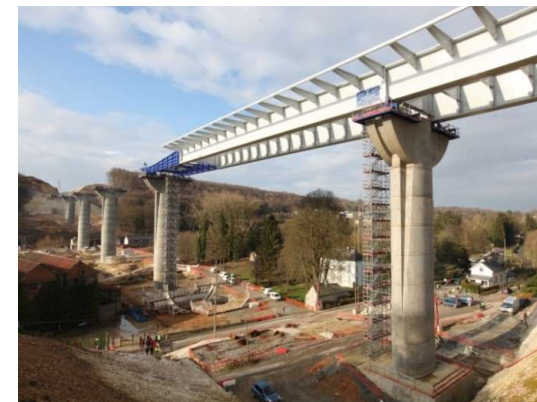
Viaduc de l'Austreberthe (A150)
