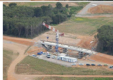
A9 – Dédoulement de l'autoroute à Montpellier (Crédits : ASF – Vinci Autoroutes)
