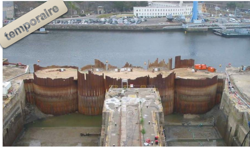
Batardeau | Arsenal de Brest | France
