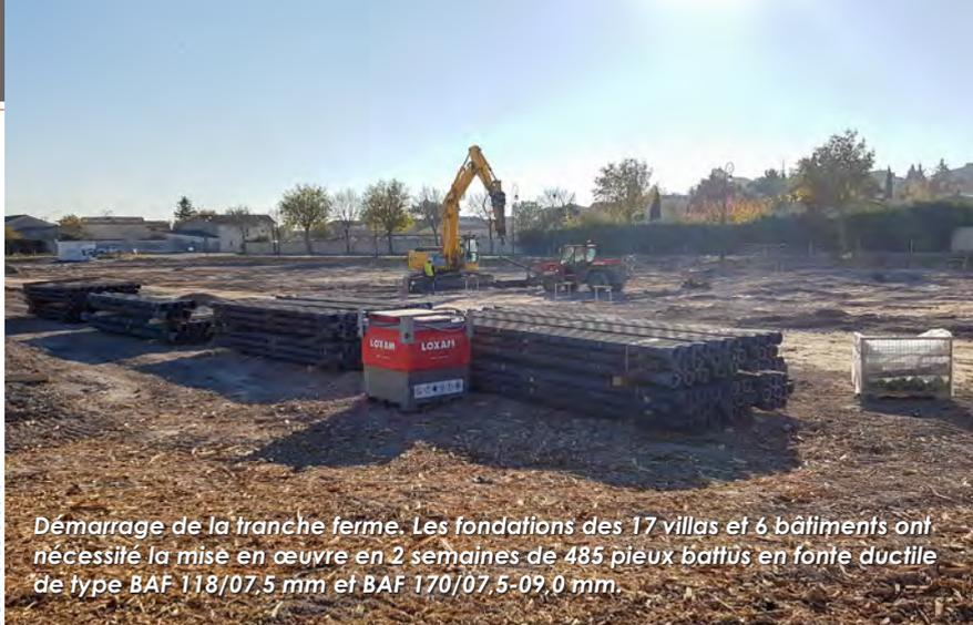
Démarrage de la tranche ferme. Les fondations des 17 villas et 6 bâtiments ont nécessité la mise en œuvre en 2 semaines de 485 pieux battus en fonte ductile de type BAF 118/07,5 mm et BAF 170/07,5-09,0 mm.
