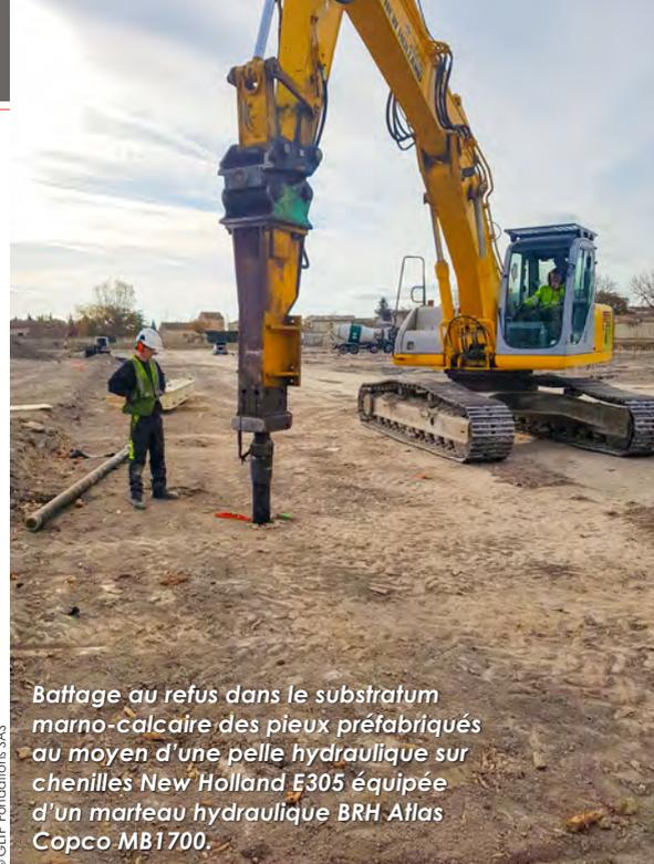
Battage au refus dans le substratum marno-calcaire des pieux préfabriqués au moyen d'une pelle hydraulique sur chenilles New Holland E305 équipée d'un marteau hydraulique BRH Atlas Copco MB1700.
