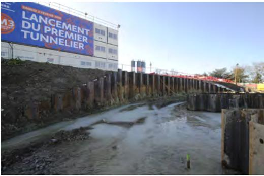
**Soutènement autostable de la base vie, h = 3,80 m en PU 28 de 13 m.**
