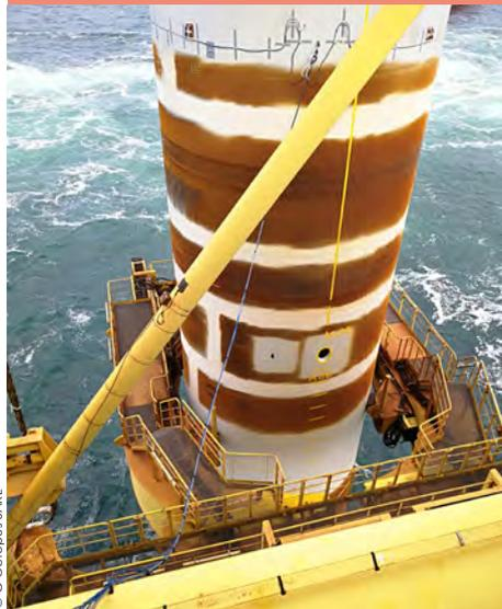
Mise en place d'un monopieu durant la campagne d'installation de Horns Rev 3.
