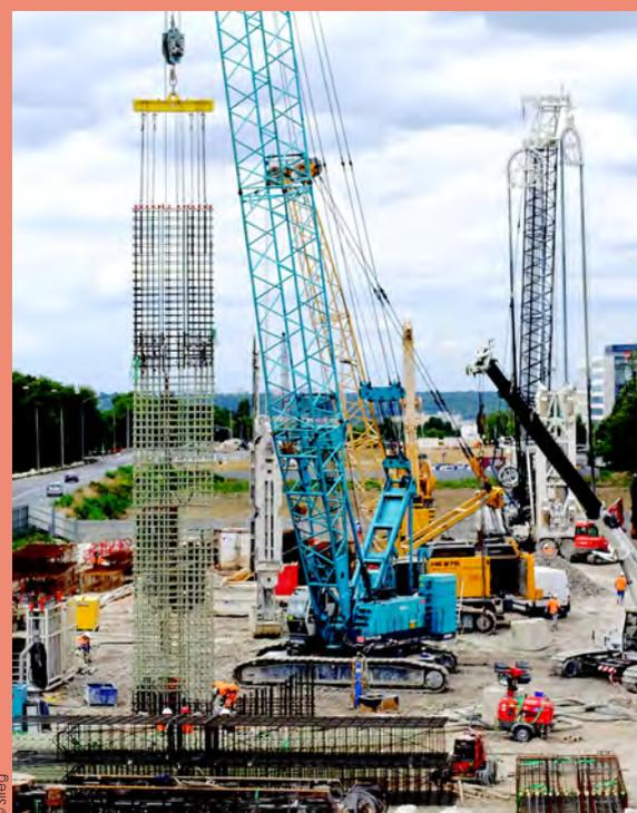
plus de 14 m de hauteur. Depuis 20 ans, Sireg fabrique et dimensionne les armatures en fibre de verre Durglass et Glaspree, selon un procédé qui s'appelle « pultrusion ». Les vérifications des portions des panneaux à renforcer avec des barres en fibre de verre se font en partant des sollicitations et des plans des armatures en acier en utilisant des normes spécifiques pour les matériaux composites.
