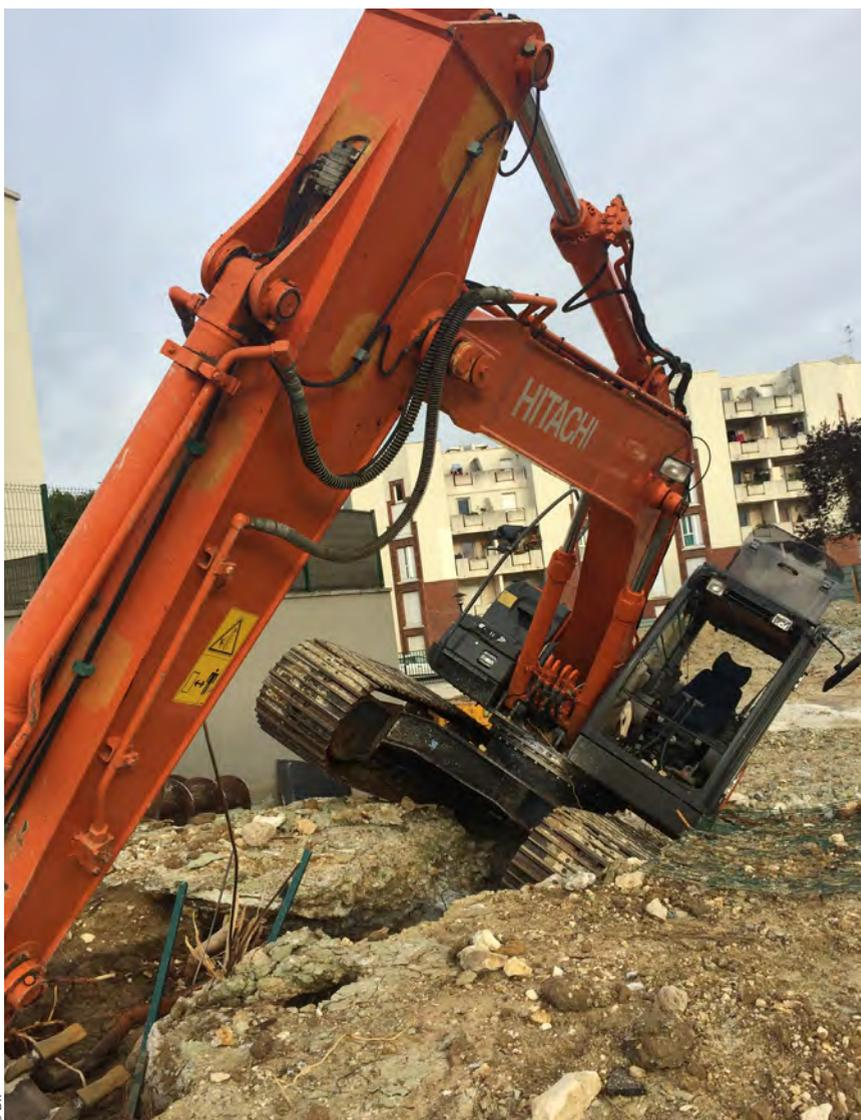
*Suite à la rupture d'une canalisation d'eau potable, renversement d'une machine consécutif à l'inondation du chantier.*
