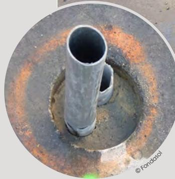
... Autre illustration à Antony, où la construction d'un EHPAD a nécessité le traitement préalable des zones de terrain très décomprimées par effondrement du toit des niveaux exploités au sein des masses et marnes du gypse du Ludien, et partiellement remblayées. Lors des investigations menées en étude G2, les enregistrements de paramètres de forage ont permis à Fondasol de localiser les niveaux à traiter, et de
