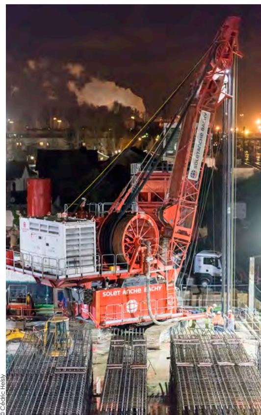
**Hydrofraise sur le Vert-de-Maisons – mise en place de joints CWS à 72 m de profondeur.**
