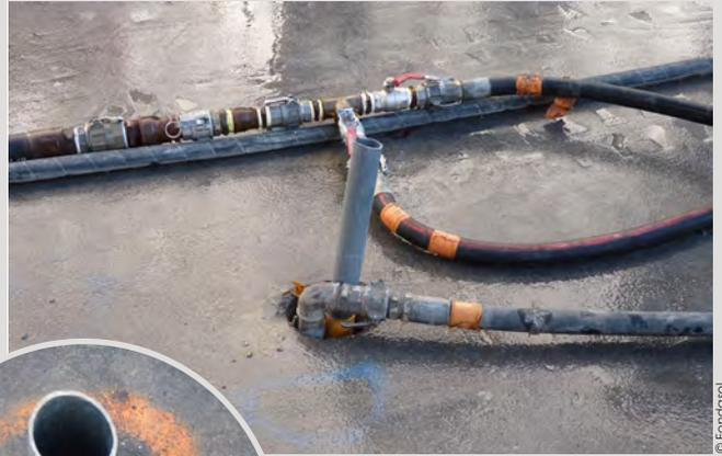
Figure 11 : Remplissage gravitaire du forage B08 (Institut La Tour, Paris 16<sup>e</sup>).
