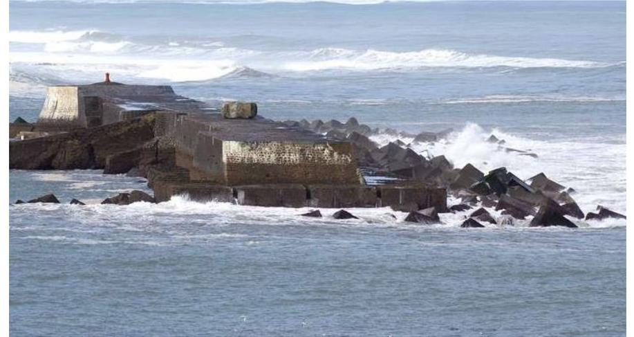
Bloc béton de 50T déposé sur la digue de l'Artha (St Jean de Luz)
