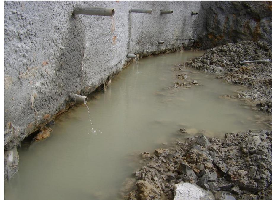
Écoulement des eaux de la nappe en phase travaux
