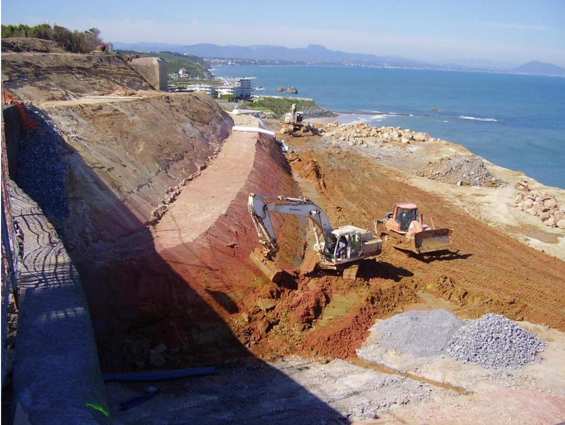
**Remodelage du profil** de la falaise par des **terrassements en déblai / remblai** penté à 3H/2V (terrain en place) à 2H/1V (remblai) avec alternance de talus et de risbermes et :
