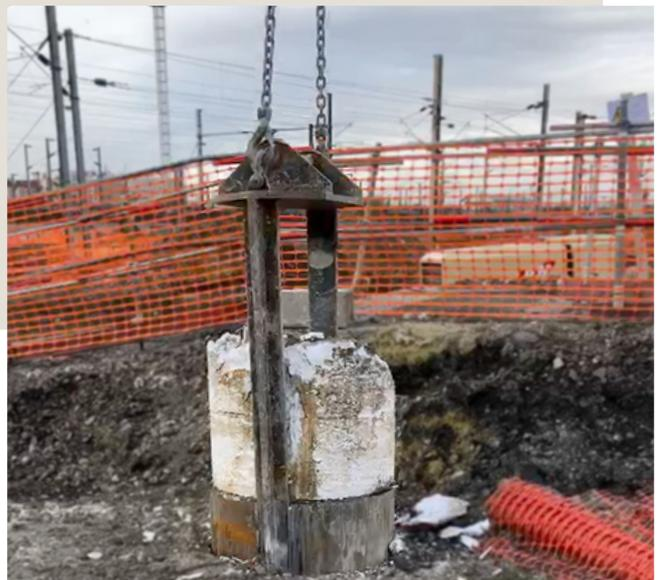
Cela mobilise du temps, du personnel, du matériel et comporte de nombreuses situations à risques. L'énergie nécessaire à l'excavation du polystyrène est supérieure à celui de sa production et la proximité des ouvriers lors de la manutention est risquée (éclats de métal ou de pierres possibles, la mise en tension des chaînes de levage ainsi que surexploitation des manilles).
