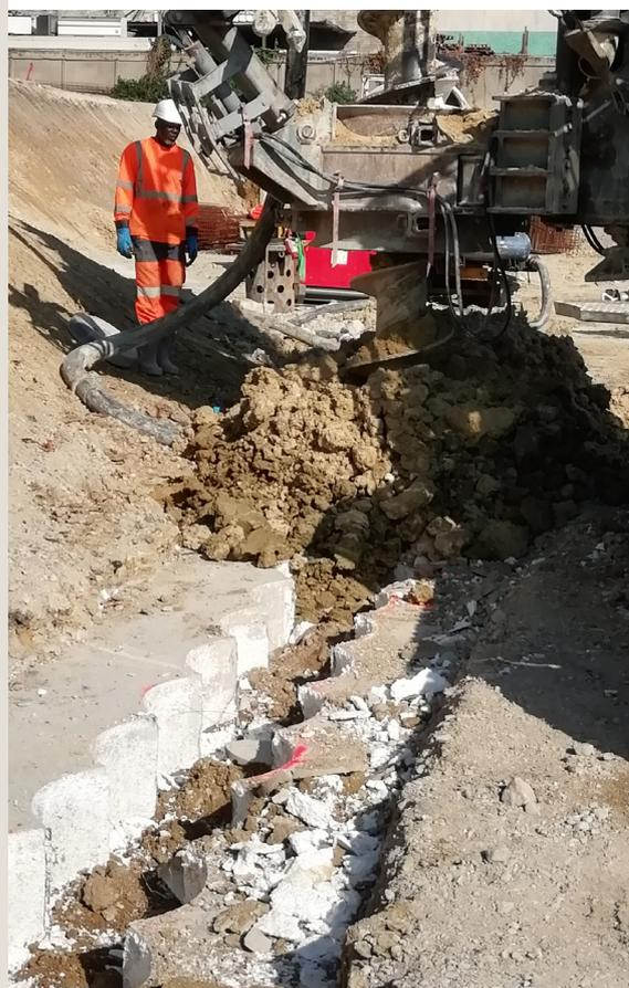
*forage de la murette après excavation du polystyrène*
