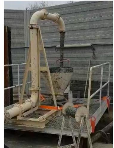
Pour ce qui est de la coupure de la colonne, le principe est identique à un bétonnage classique : l'entonnoir est relevé à la main (1), la grue de manutention extrait une certaine longueur de colonne (2) et la range dans le rack. La pièce intermédiaire (3) est ensuite fixée sur le reste de la colonne encore dans le forage, l'entonnoir est remis à la main (4) et le bétonnage peut recommencer (5).
