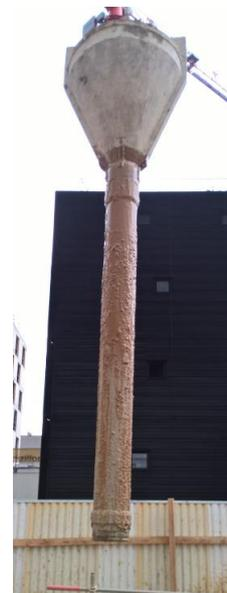
(1) Colonne de bétonnage égale à la longueur du forage
