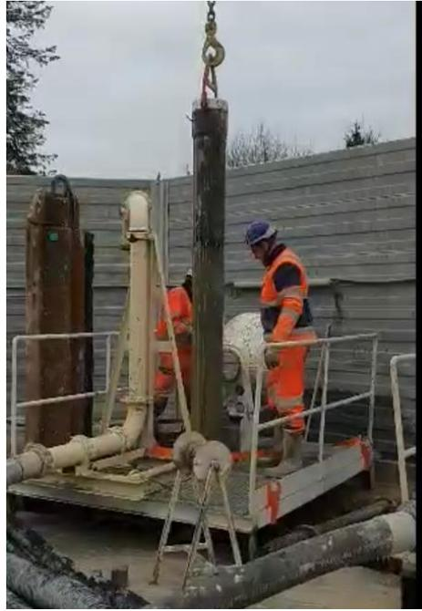
Une fois la colonne posée sur le frein, le Manoeuvre insère **la pièce intermédiaire** permettant d'assurer une continuité entre l'entonnoir et le reste de la colonne. Cette pièce est maintenue à l'aide d'une câblette identique au reste de la colonne.
