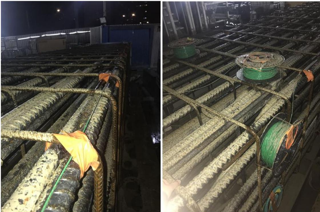
Figure 7: Photographie du CFOR SensoLux TMA installé sur la cage C7c
