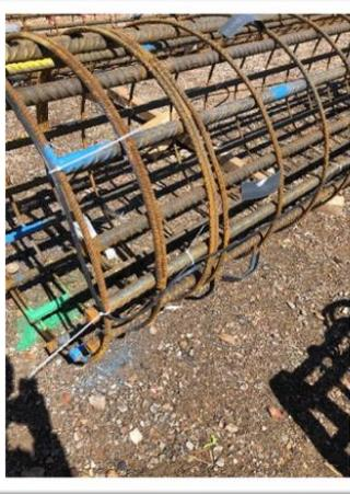
Old Oak Common Station : Mesure répartie de déformation et température par CFOR SensoLux TMA® . Royaume Uni - 2021.
