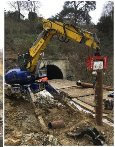
Levages foreuses 15 / grue KIROW – Monitoring prédictif – Vibrofonçage pré-tubes pieux racines (au refus)
