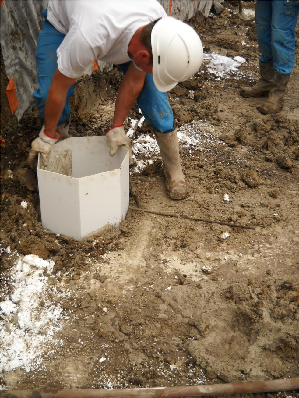
Puis on introduit dans le béton frais de la tête de pieu à recéper le ou les éclateurs (selon le diamètre des pieux à PRÉ-RECÉPER), jusqu'à l'altitude prévue du PRE-RECEPAGE.
